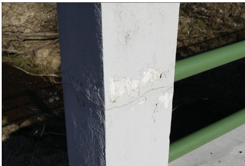
Poruchy sloupků zábradlí
