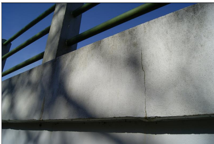
Trhliny v sanační omítce na římsách
