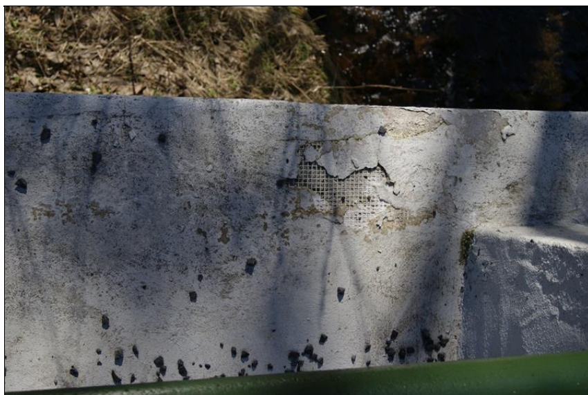
Poruchy sanace říms
