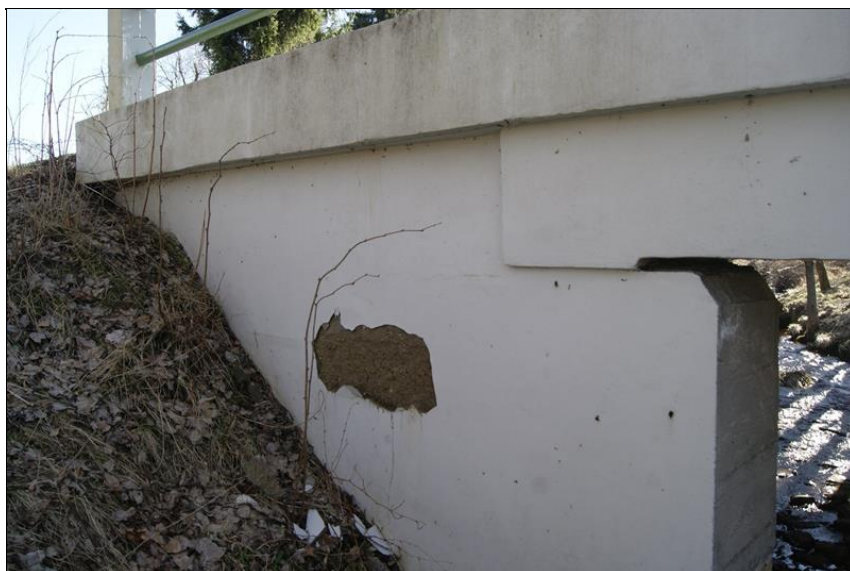
Lokální poruchy a odpad sanační omítky na pravobřežním výtokovém křídle
